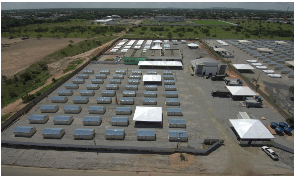
Figura 3: Vista aérea do abrigo Rondon 2, em Boa Vista - Capacidade para 645 abrigados
